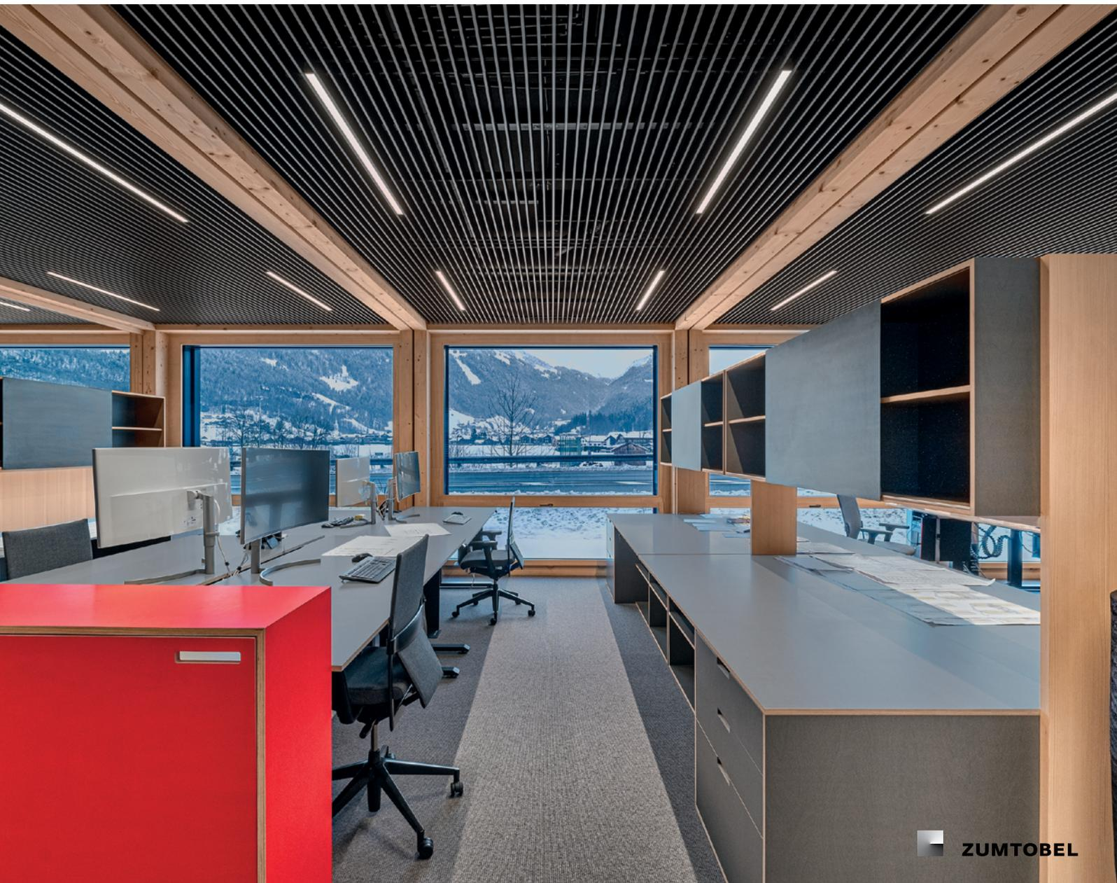
Dank ihrer geringen Aufbauhöhe und ihrer exzellenten Entblendung lassen sich ZUMTOBEL Lichtbänder flächendeckend und unkompliziert in das HAUFE Lamellensystem einbinden. Die Lösung vereint Ästhetik, Licht, Klimatisierung und Schallschutz.
